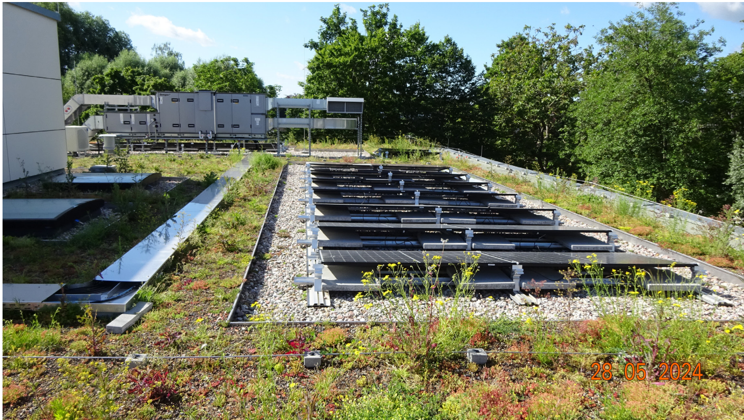
Beispiel: Dach der baugleichen Kita Minimax.
