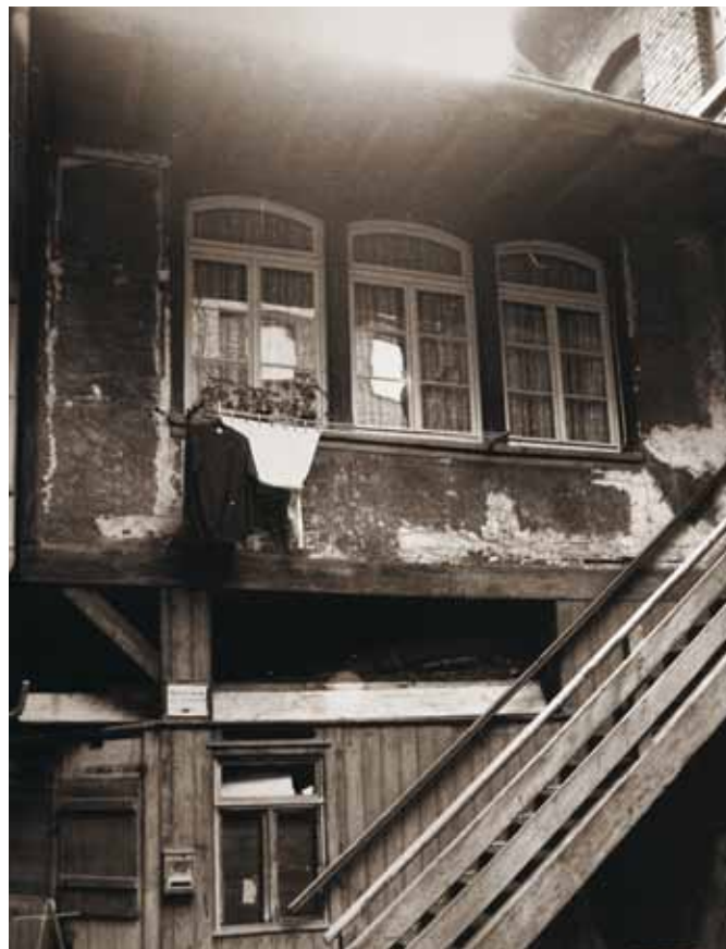
Abbildungen: Oben: Alte Bebauung Hollagäßchen/Kirschgarten vor der Sanierung Unten: Neubau Ansicht vom Hollagäßchen
