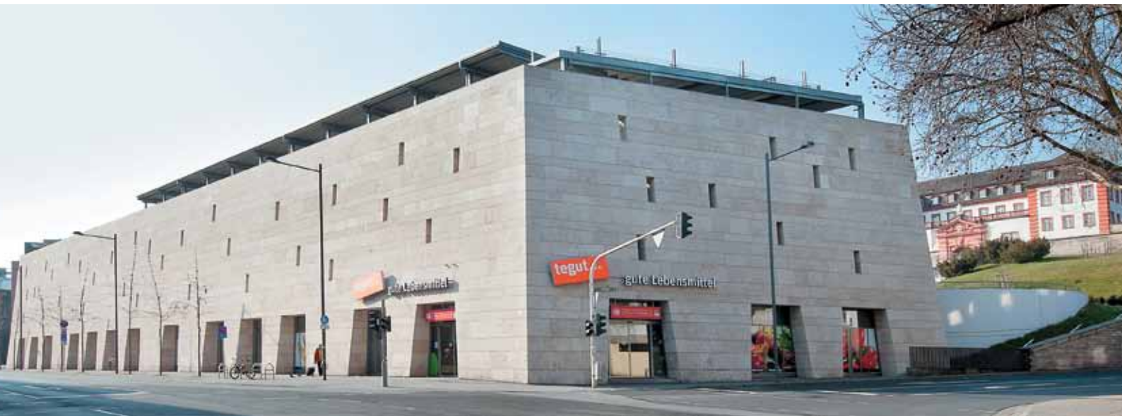
Abbildungen: Links oben: Eingang Bahnhof „Römisches Theater“ Links unten: Ansicht Büro- und Geschäftshaus von der Holzhofstraße Rechts oben: Parkhaus „Römisches Theater“ Rechts Mitte: Wo heute das Parkhaus steht, gab es jahrelang eine Brachfläche vor der Sanierung
