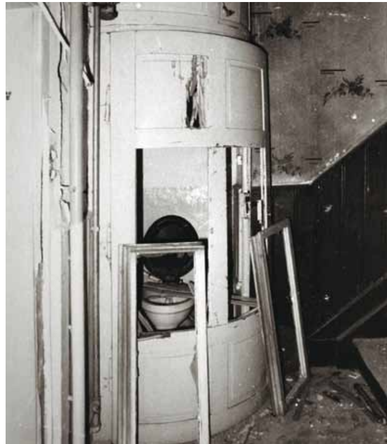
Abbildungen: Links: Kappelhof 5-7 Mitte: Sanitäre Anlagen in der Holzhofstraße 24 Rechts: Heringsbrunnengasse
