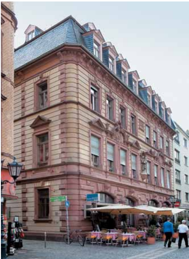
Abbildungen: Oben: Der Frankfurter Hof vor der Sanierung Mitte: Ansicht von der Augustinerstraße Unten: Entrée im Erdgeschoss Rechts: Foyer mit Galerie
