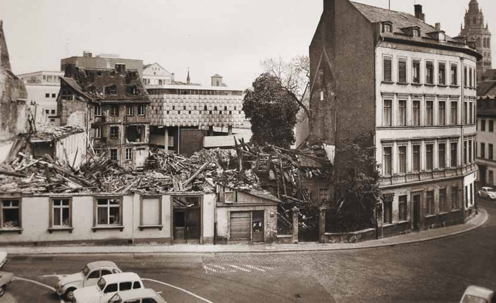
Abbildungen: Oben: Abrissarbeiten für den Bau der Altstadttangente im Bereich Pfaffengasse/Weihergartenstraße vor der Sanierung Unten: Weißliliengasse, Blick Richtung Süden
