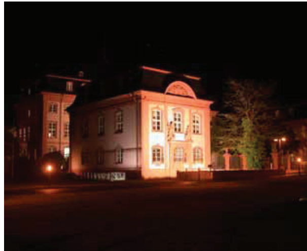
8 Torgebäude Landtag - unvollständige Beleuchtung
