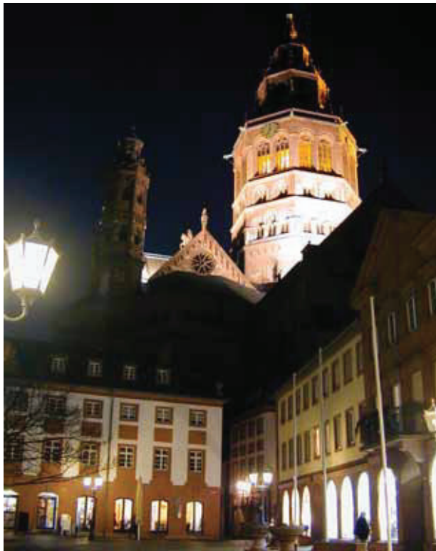
7 Dombelichtung - fehlende Beleuchtung der Turmspitze etc.
