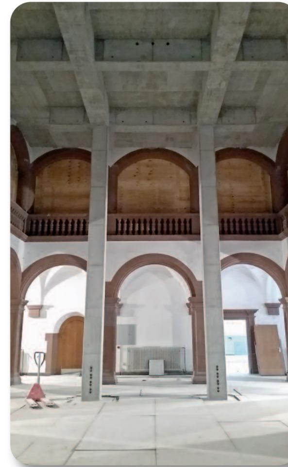
Neue Betonstützen und Zwischendecke im Lichthof
